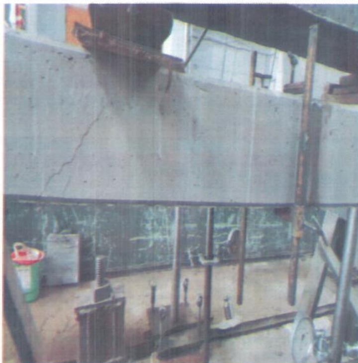
Фото № 2. Наклонные трещины шириной раскрытия до 0,2 мм при разрушающей нагрузке приложенной к перемычке СПБ25-37
